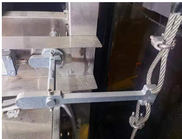
图 2 钢丝绳连接示意图（图片供参考）
